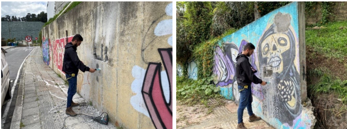
Figura 7. Potencial de corrosión caso 1 (Izquierda) y caso 2 (Derecha)
