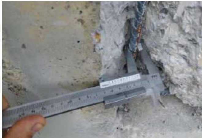
Figura 6. Registro regata #1, muro de contención caso 1. Fuente: Caisan Ingeniería
